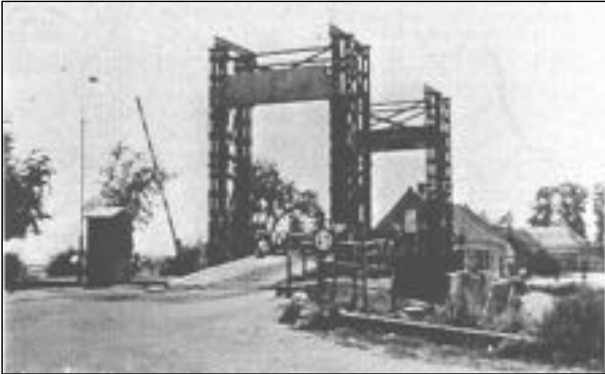
Spandau Bridge Sluis 11 Someren, van begin 1945 tot juni 1946.
